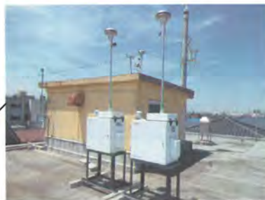
石巻局(石巻市蛇田支所)
