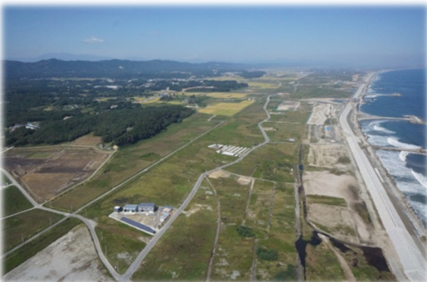
山元東部地区 工事着手前(平成27年9月)
