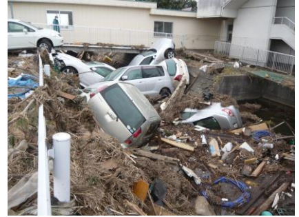
農業用幹線排水路の被災(亘理町)
