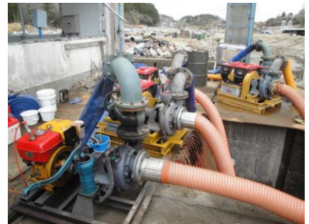
応急ポンプ設置(東松島市)
