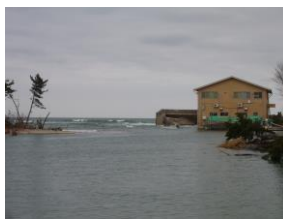
震災直後の吉田排水機場
