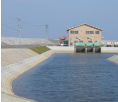
吉田排水機場の復旧状況(H26.5)
