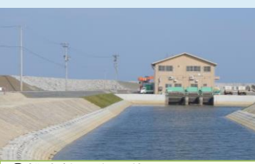
⑫排水機場復旧状況 (亶理町:吉田排水機場)
