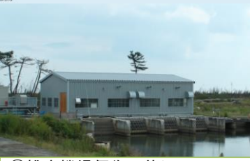
⑨排水機場復旧状況 (仙台市:二郷堀排水機場)
