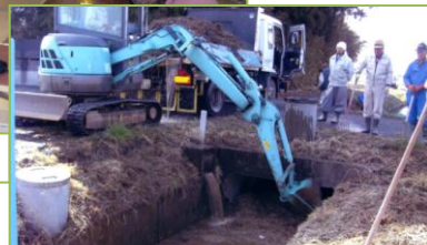
水路に堆積したいなら等の礫撤去作業
