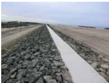
農地海岸の2次復旧完了(亘理町)
