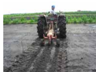
除塩実証試験:暗渠設置(名取市)
