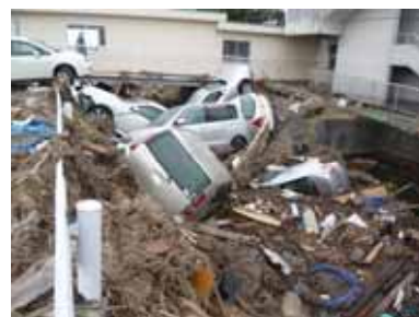
農業用幹線排水路の被災（巨理町）
