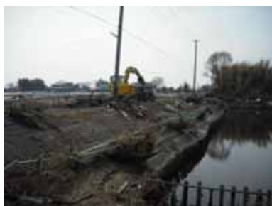
災害廃棄物の処理（名取市）
