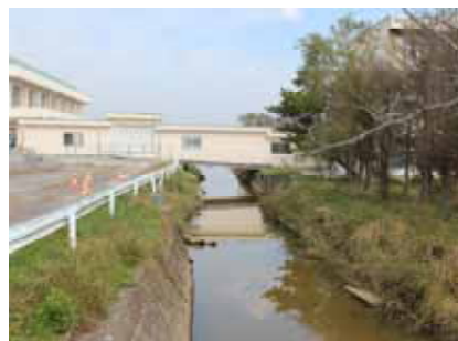
廃棄物処理後の農業用水路(巨理町)
