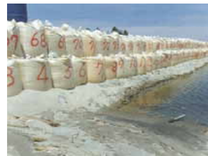
農地海岸の1次復旧完了(巨理町)
