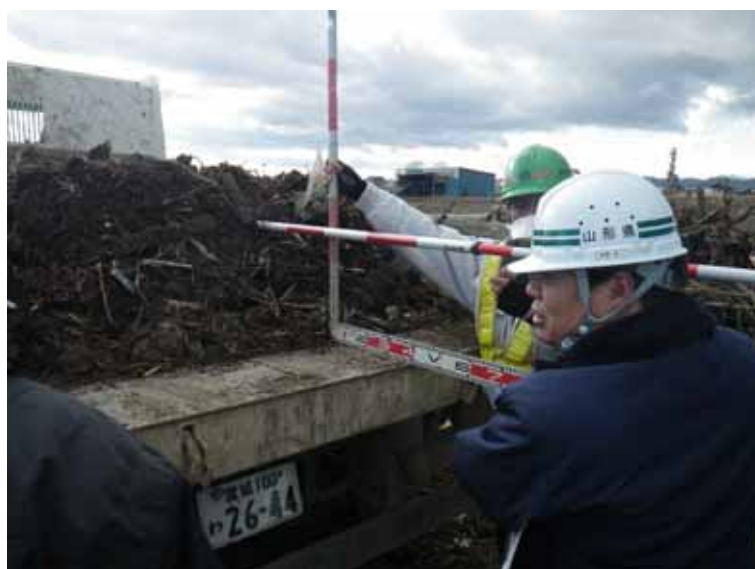
工事の管理 (右から1番目: 山形県派遣)
