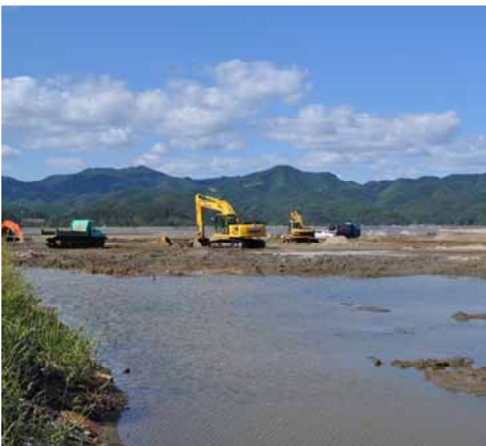
干陸化が始まり重機が入った様子(平成24年9月26日)
