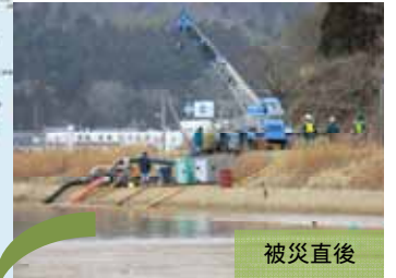
被災農地復旧状況 (石巻市:飯野川地区)
