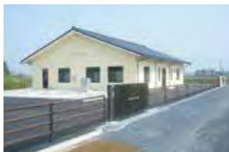
農業集落排水事業 長谷地区(登米市)
