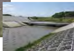
下：県営迫川上流地区 （栗原市・熊川頭首工）
