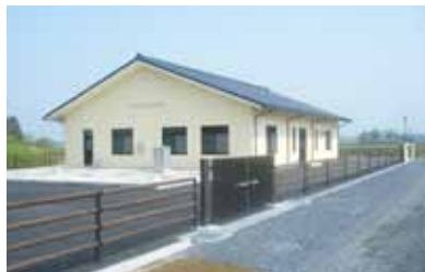
農業集落排水事業 長谷地区（登米市）
