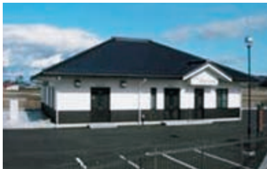
村づくり交付金（農業集落排水単独事業） 田尻第2地区（大崎市）
