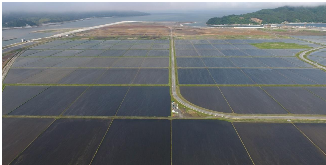
営農を再開した農地（手前）と工事中（奥）の石巻市大川地区（令和元年5月）
