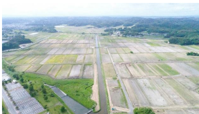
区画整理工事実施前（平成30年6月）
