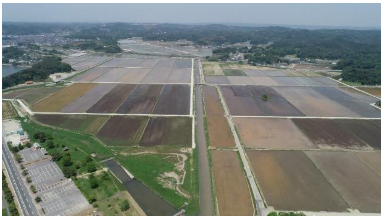
区画整理工事実施後（令和元年5月）
