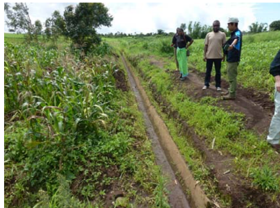
写真 74：槻田技師が設計・施工した水路
