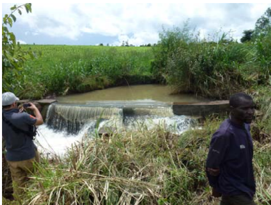
写真 73：マビンジャ地区取水堰
