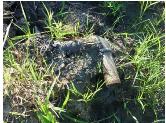
写真 34 : 給水栓（1970 年代設置）
