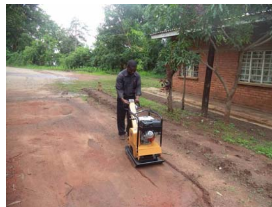
写真 83, 84: 振動コンパクトの作動確認状況
