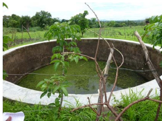
写真 66 : 夜間取水した水を利用した貯水槽
