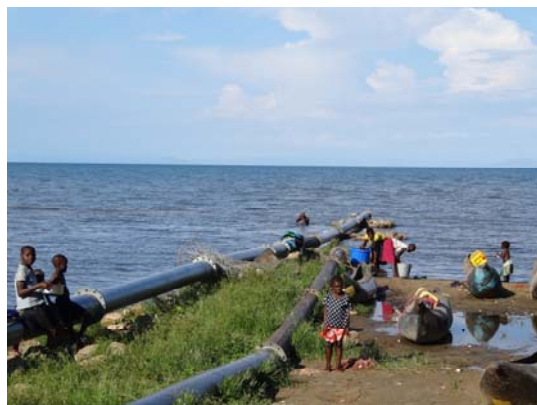
写真 28：マラウイ湖からの取水
