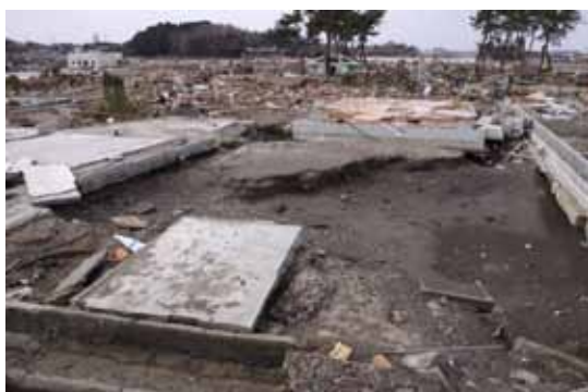
▲写真 宮城郡七ヶ浜町 七ヶ浜土地改良区被災写真
