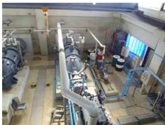
▲写真 応急復旧後の排水機場（H24年1月）
