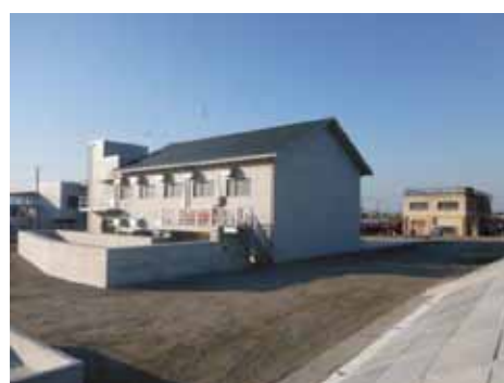
▲写真 閑上排水機場復旧状況
