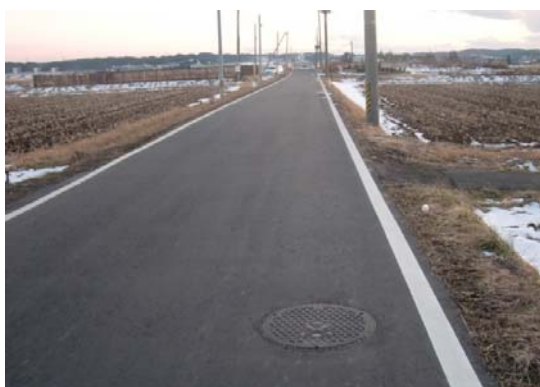
▲写真 復旧後の管路施設（H24 年 12 月）
