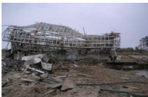
▲写真 山下第8揚水機場（山元町）被災状況
