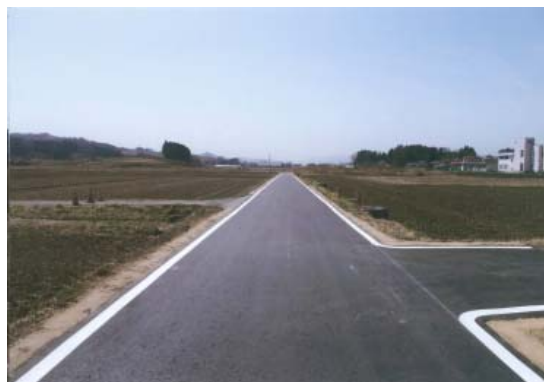
▲写真 復旧完了状況
