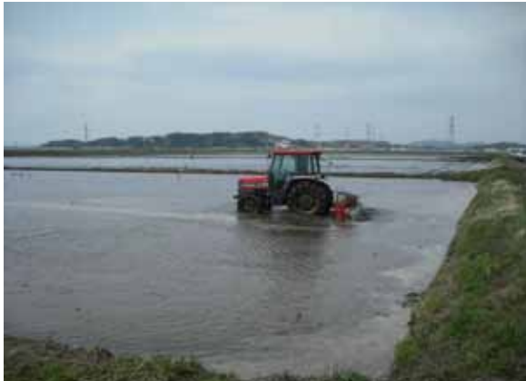
▲写真 除塩作業実施状況 (H23年4月)
