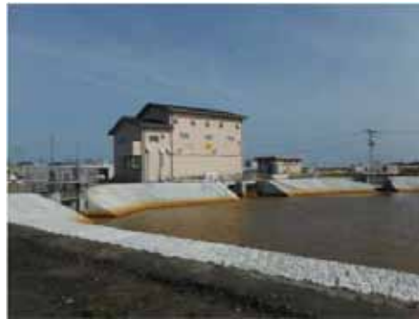
▲写真 大曲排水機場復旧状況
