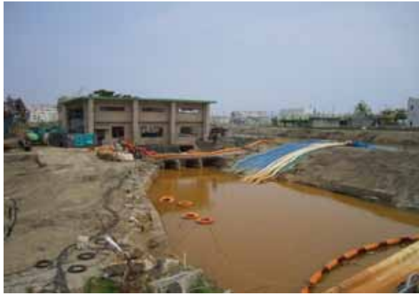
▲写真 高砂南部排水機場(仙台市)
