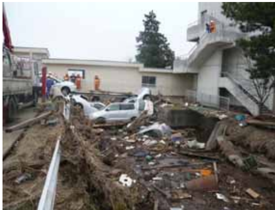
▲写真 被災直後の排水路（H23年3月）
