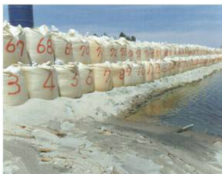
▲写真 農地海岸応急復旧（亶理町）
