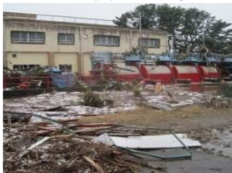
▲写真 閑上排水機場（名取市）被災状況
