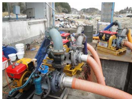
▲写真 応急ポンプによる湛水排除（左：名取市 右：東松島市）
