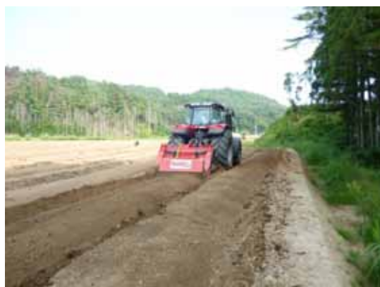
▲写真 南三陸地区ストーンクラッシャ施行状況 （南三陸町）
