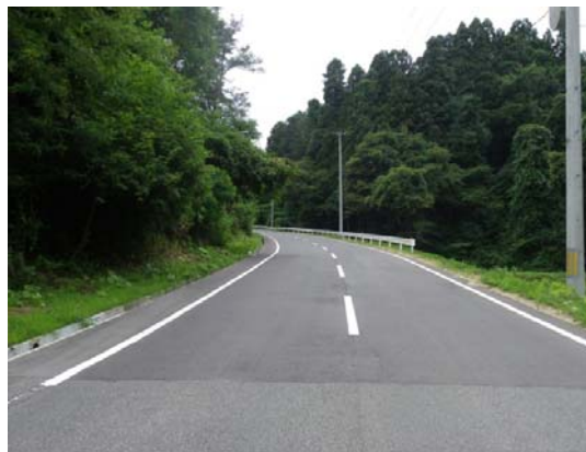
▲写真 復旧完了状況
