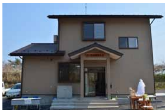
▲写真 宮城郡七ヶ浜町 七ヶ浜土地改良区完成写真
