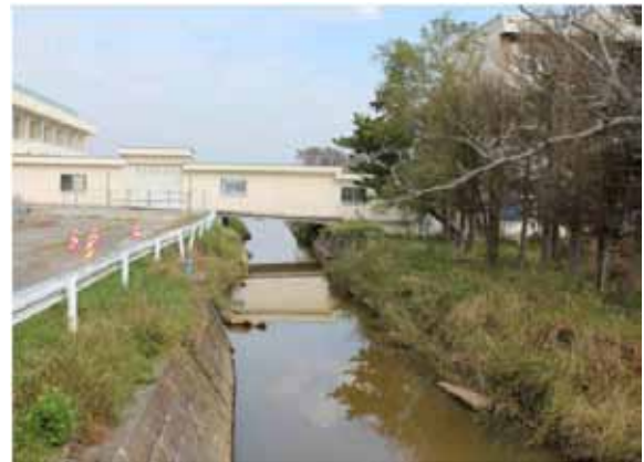
▲写真 災害廃棄物撤去後の排水路（H23年11月）
