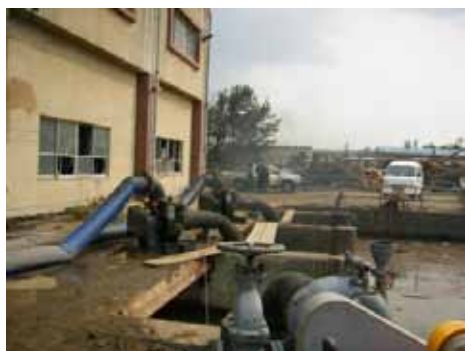
▲写真 応急ポンプによる湛水排除（左：名取市 右：東松島市）
