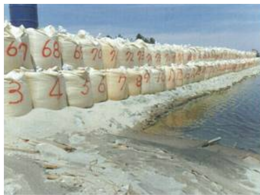
▲写真 農地海岸の応急復旧（県施工 H23年4月）
