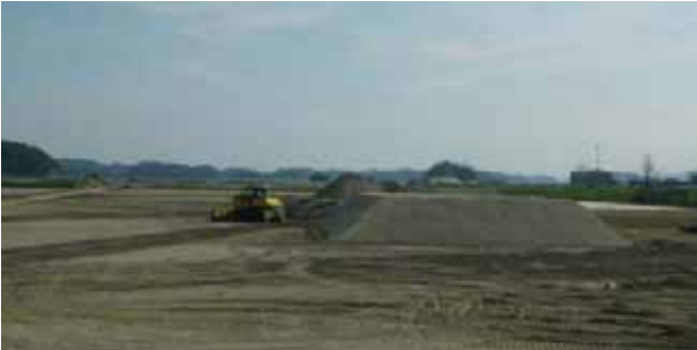
▲写真 奥松島地区客土施行状況（東松島市 H27 年）
