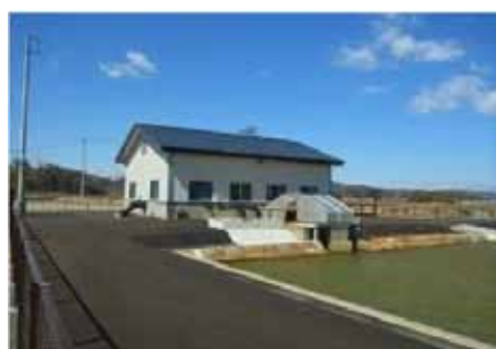
▲写真 山下第8揚水機場復旧状況
