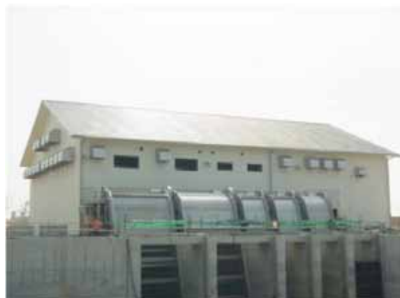
▲写真 二郷堀排水機場復旧完了状況
