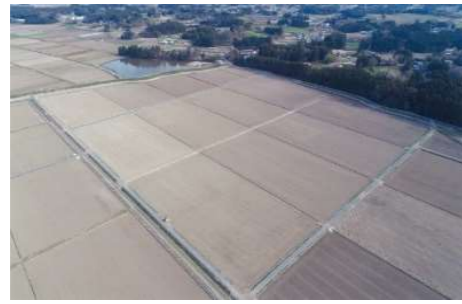
大区画ほ場整備（蕪栗沼地区）
