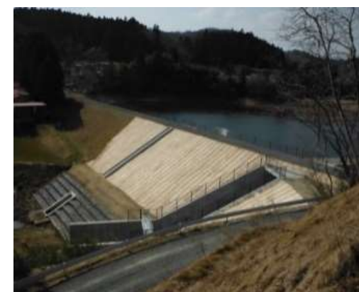
〔災害被害防止のため整備が進む農業用施設 (ため池：大崎市)〕
