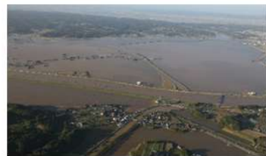
豪雨による甚大な湛水被害
