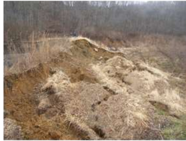
地震による堤体の崩壊
