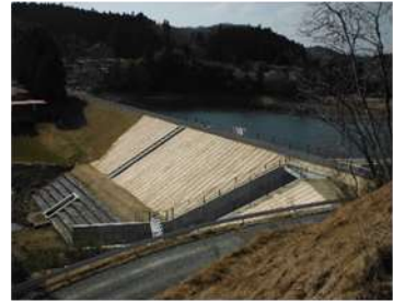
対策工事の実施
