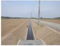
排水路の整備
