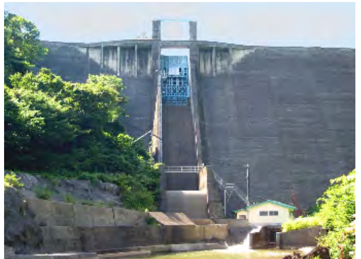
▲沼倉1期地区(ため池等整備)・・・クレストゲート改修(栗駒ダム)
