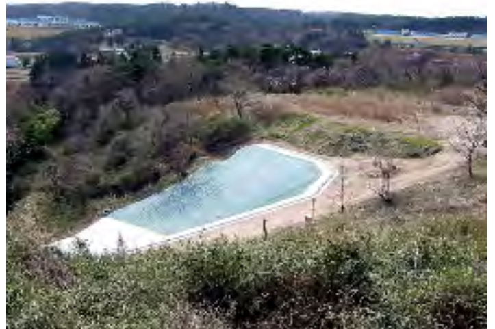
▲館下地区(地すべり対策)
