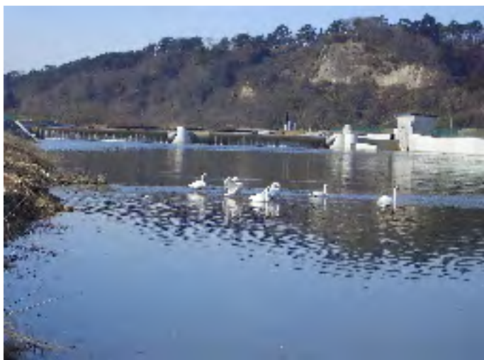
▲迫川上流3期地区(県営かんがい排水)・・・秋山頭首工
