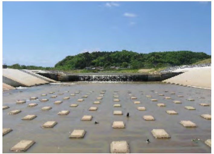
▲迫川上流地区(県営かんがい排水)・・・熊川頭首工
