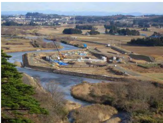
▲迫川上流3期地区(県営かんがい排水)・・・秋山頭首工の工事状況
