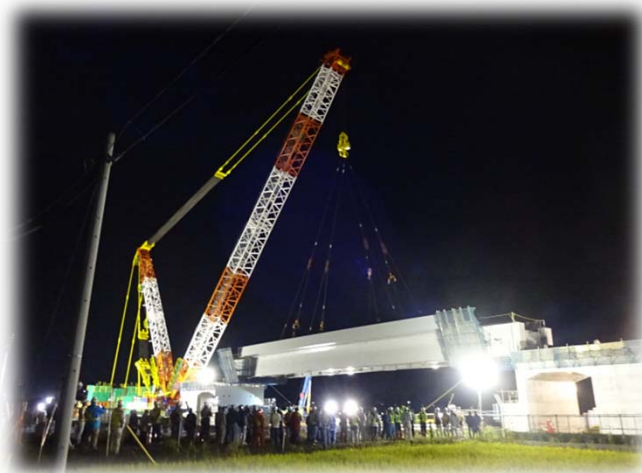
橋桁架設状況
