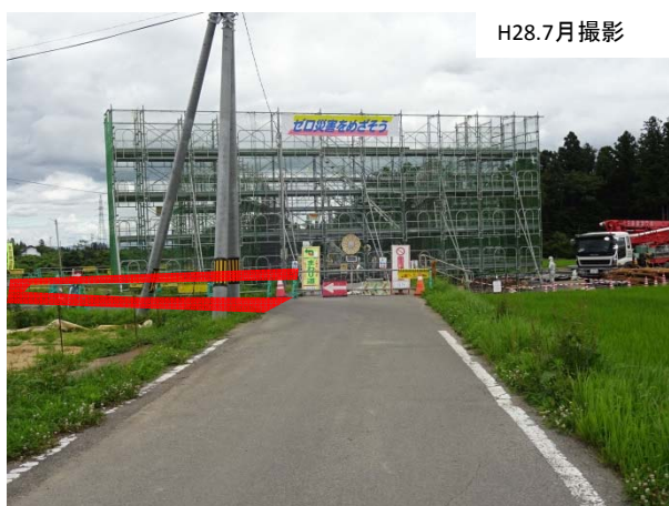
写真-2-2 9号函渠工工事の状況(外観)
