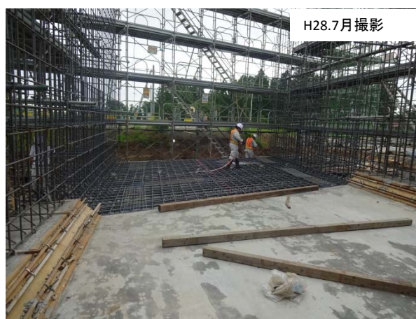
写真-2-3 9号函渠工工事の状況(内部)
