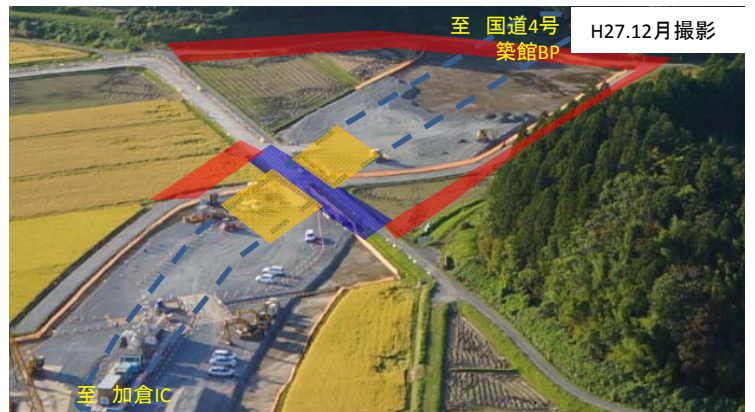
写真-4 萩沢前本線橋の規制予定
