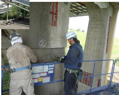
主要地方道 古川松山線 敷玉橋の施工状況
