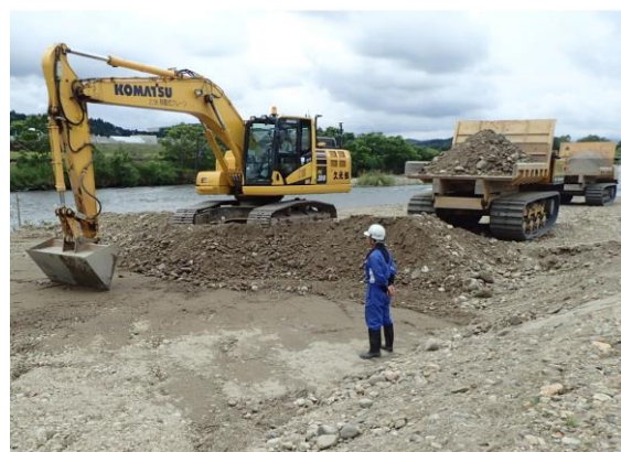
江合川の堆積土砂掘削状況（2）
