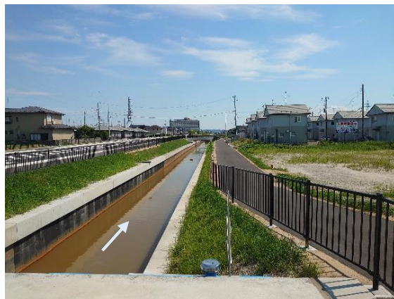
令和2年度整備完了状況
