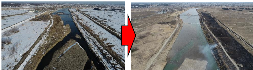
堆積土砂及び支障木の撤去状況(令和2年度施工) <一級河川鳴瀬川水系鳴瀬川>
