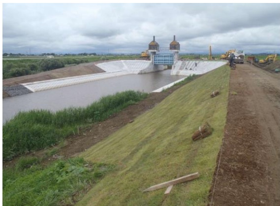
佐賀川水門取付護岸の施工状況(R3.7)
