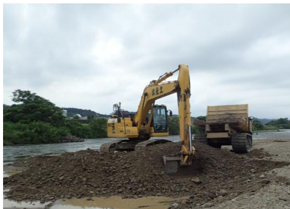
江合川の堆積土砂掘削状況（1）
