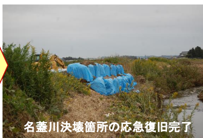
渋井川決壊箇所の応急復旧完了
