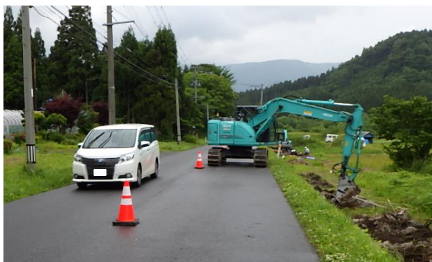
岡台工区の施工状況
