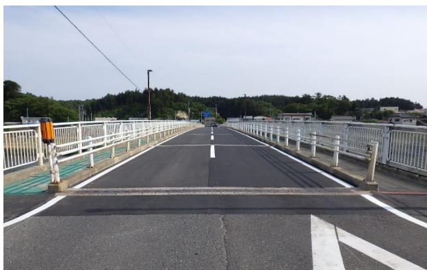
一般県道涌谷三本木線 三本木橋の補修完了状況
