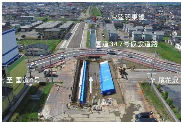
国道347号橋梁箇所の施工状況
