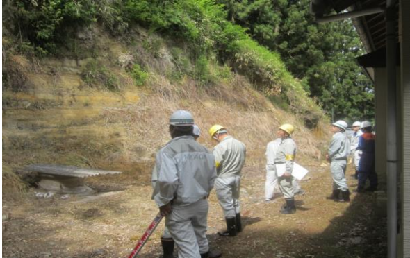
大崎市古川落合地区の点検状況
