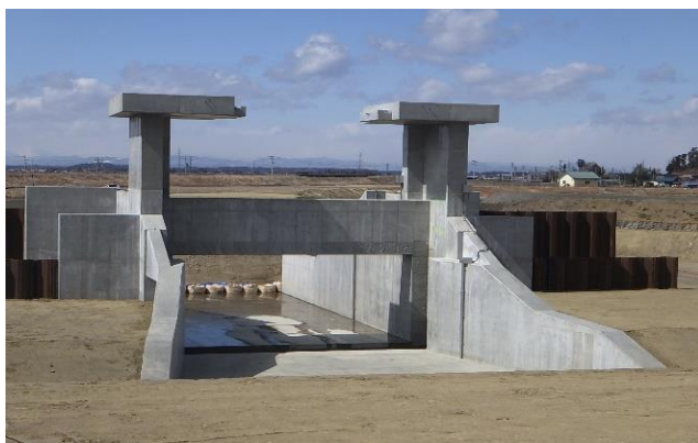
佐賀川水門の施工状況
