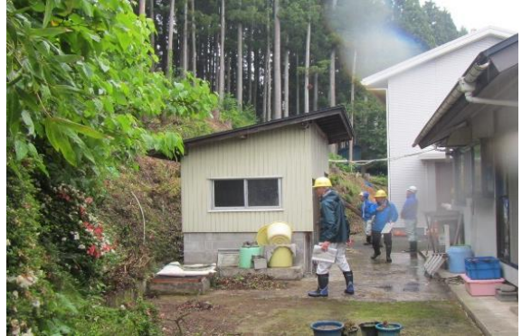
加美郡色麻町平沢地区の点検状況
