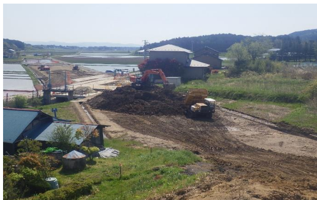
大貫工区の施工状況
