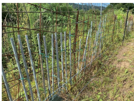
鉄筋棒による修復跡
