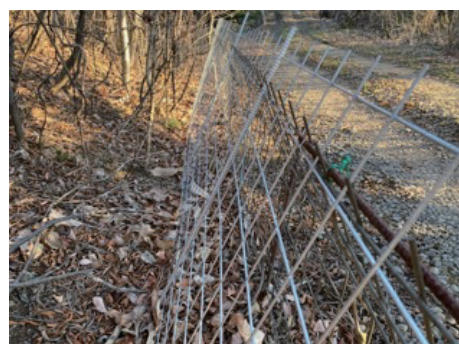
斜めに立てかけた補強例
