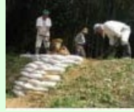
漏水箇所の補修
