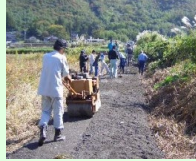
未舗装農道の舗装
