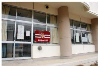
仮設職員室の設置 ここから再生に向けて踏み出す
