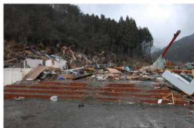
体育館は 入り口の階段だけが残った
