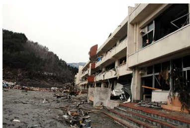
15時25分 校舎の屋上を津波が越え すべてが廃墟と化す
