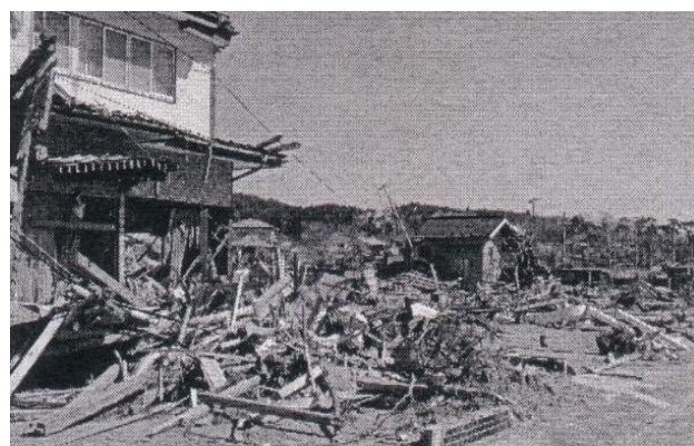
瓦礫に挟まれたバス経路（鳴瀬コース）
