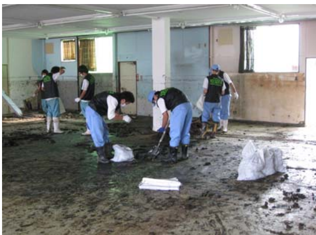
ヘドロ出し作業
