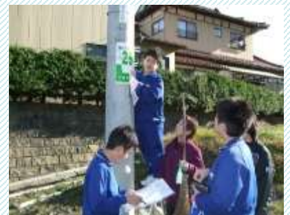
●取り付け作業
