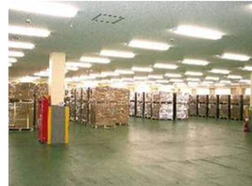
空調機能付き保管倉庫、定温保管
