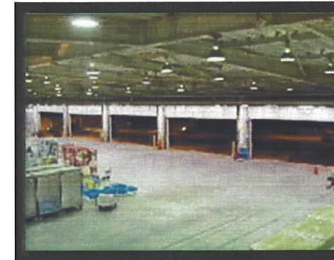
荷捌きスペース & 保税蔵置場
