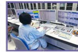
▲中央監視室 浄化センターの機械をコンピューターによって操作、監視しています。
