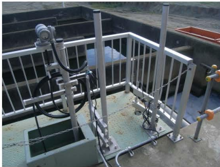
▲放流水質測定装置設置状況
