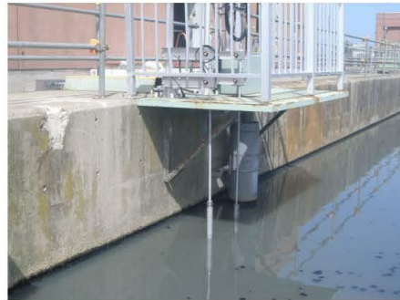
▲放流水質測定装置設置状況
