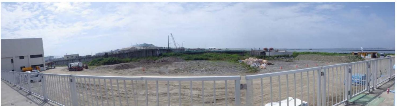
⑭処理場内から瓦礫搬出完了（H24.7月）
