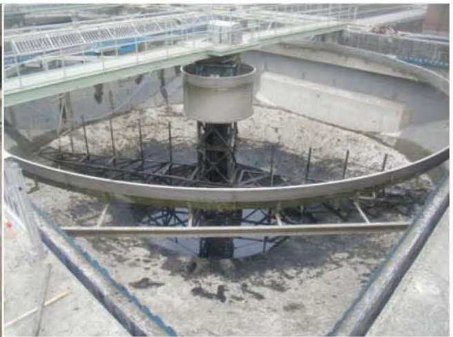
①瓦礫撤去後
