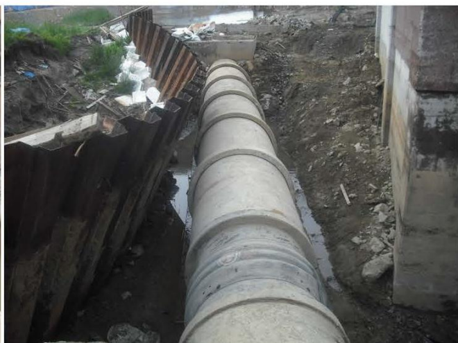
⑨放流管の復旧 (H23.6 月)
