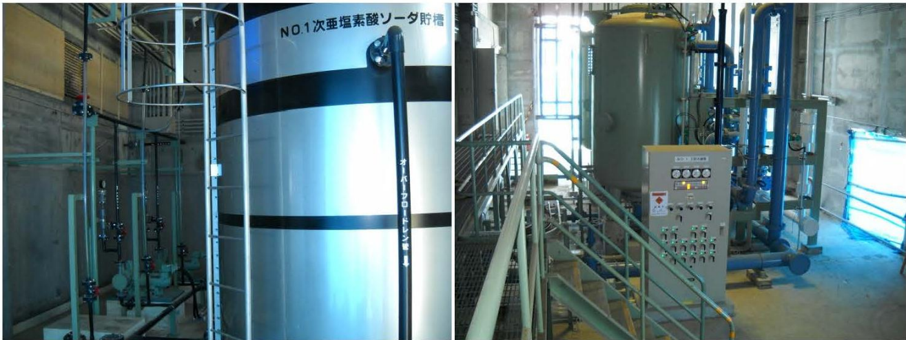
⑥次亜塩素素注入設備の復旧状況 (H24.1 月) ⑦砂ろ過設備の復旧状況 (H24.3 月稼働は水処理復旧後)
