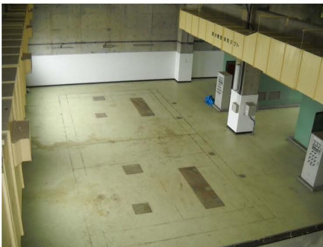
⑬脱水機棟 2階新電気室・操作室の設置前状況
