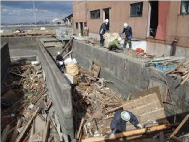
塩素混和池内の瓦礫除去状況
