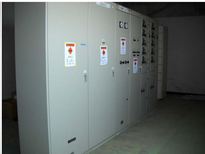
⑧砂ろ過棟電気室の復旧状況 (H24.3)
