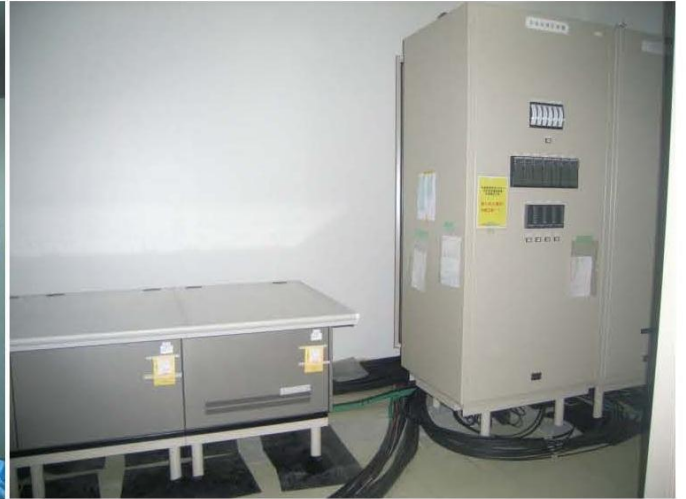
⑬新監視室への汚泥処理監視装置の設置
