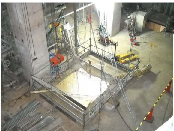
④除塵設備の撤去状況
