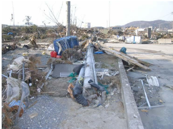
③電力引込柱の倒壊状況
