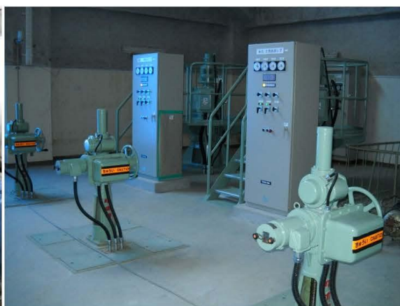
⑤段階復旧状況 (ポンプ 3 台, H23.12月・H24.2月・3月末)
