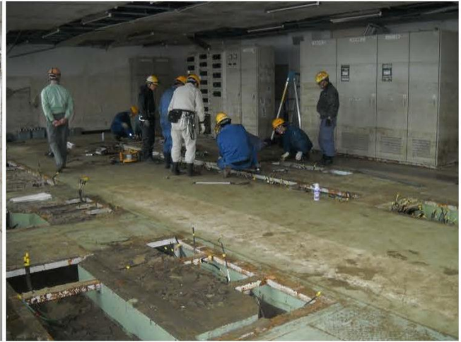
⑪脱水機棟 1階電気室の被災機器撤去状況 (H24.5月)
