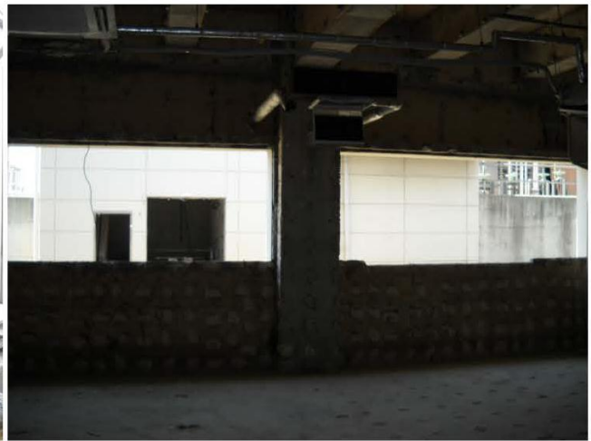
⑫脱水機棟 1階操作室の撤去状況 (H24.6月)
