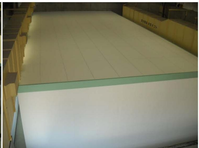
⑬脱水機棟 2階の新電気室・操作室完成 (H24.6月)
