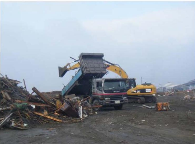
⑭処理場内へ瓦礫一時仮置き状況（被災当初）
