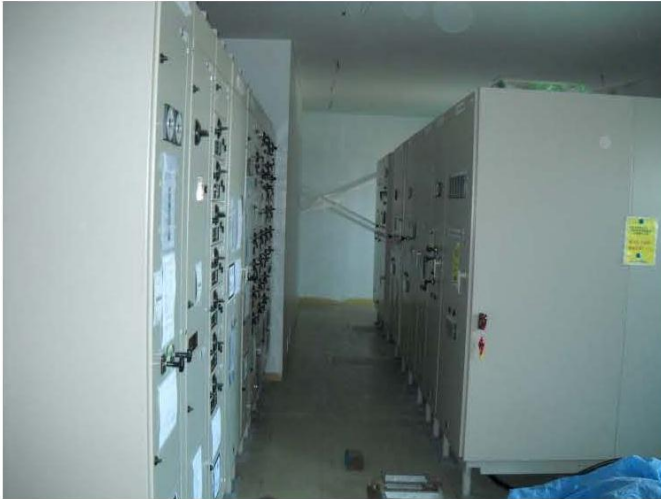
⑬新電気室への高圧盤等の設置（H24.7月末受電）
