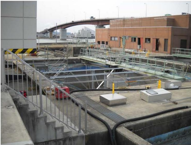
⑩簡易生物処理施設設置前の2系最終沈殿池状況
