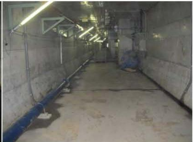
撤去完了後状況
