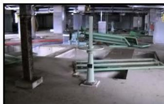
②最初沈殿池(浸水・泥堆積)
