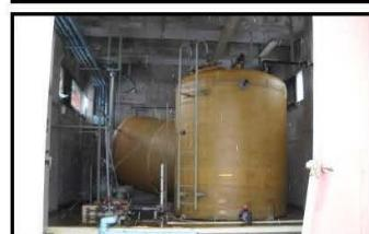
⑤消毒設備(水没・タンク倒壊)
