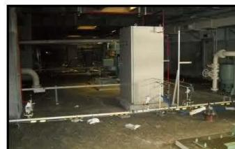
③反応タンク1・2系(浸水・泥堆積)
