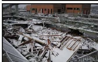
④最終沈殿池(水没)
