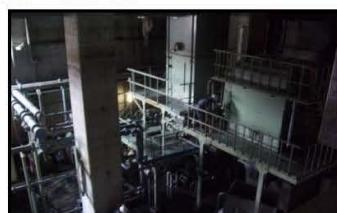
①沈砂池(沈砂機械水没)
