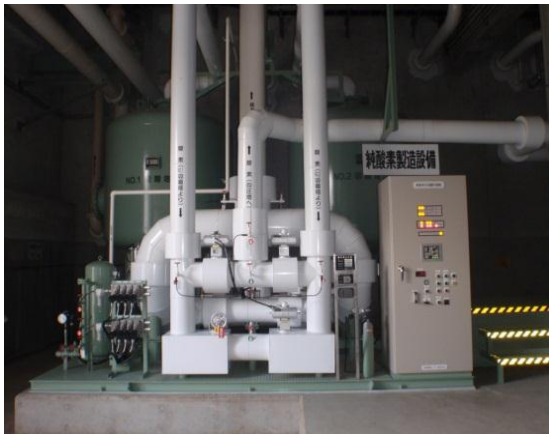
純酸素発生装置復旧状況
