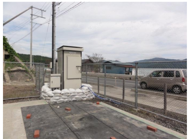
石巻第4ポンプ場臭気対策養生
