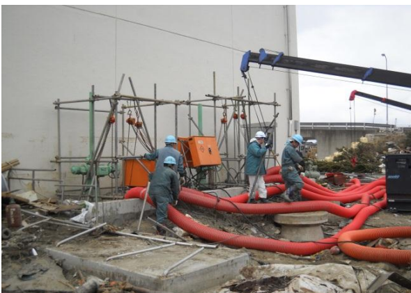
仮設ホース設置作業
