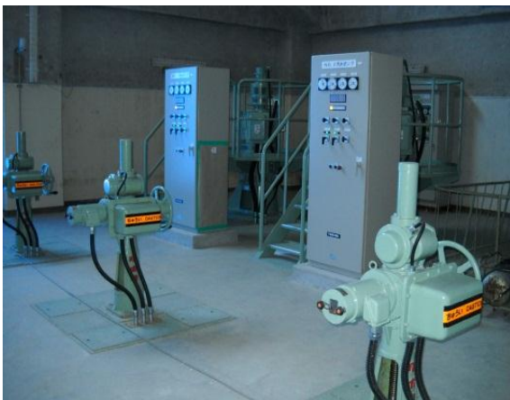
污水ポンプ盤復旧状況
