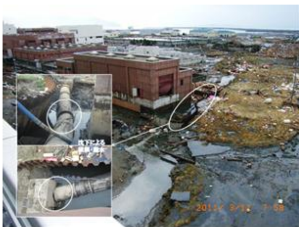
放流管破損状況
