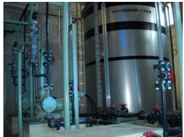
次亜塩素酸ナトリウム貯槽復旧状況
