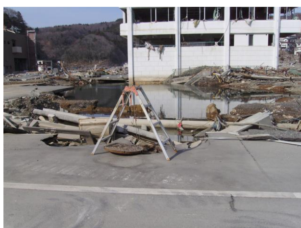
女川幹線流入点周辺被災状況
