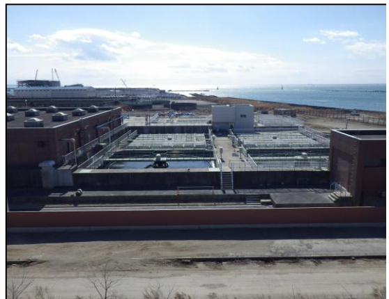
1・3系復旧状況
