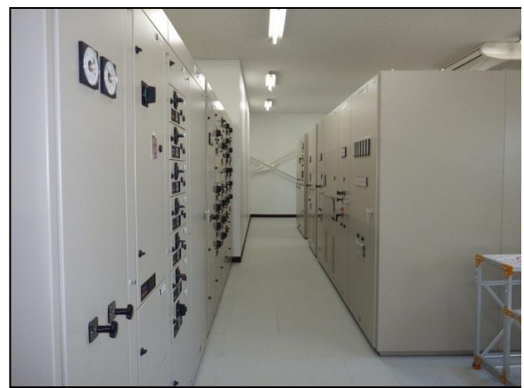
脱水機棟電気設備復旧状況
