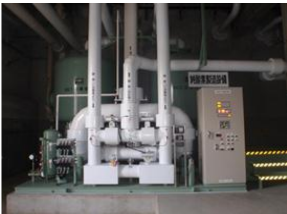
純酸素発生装置復旧状況
