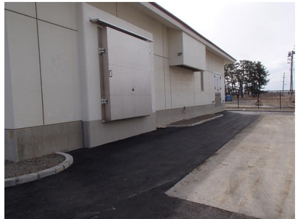
石巻第6ポンプ場電気室防水扉設置状況
