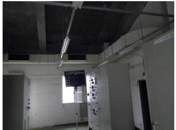
石巻第6ポンプ場新棟電気室復旧状況
