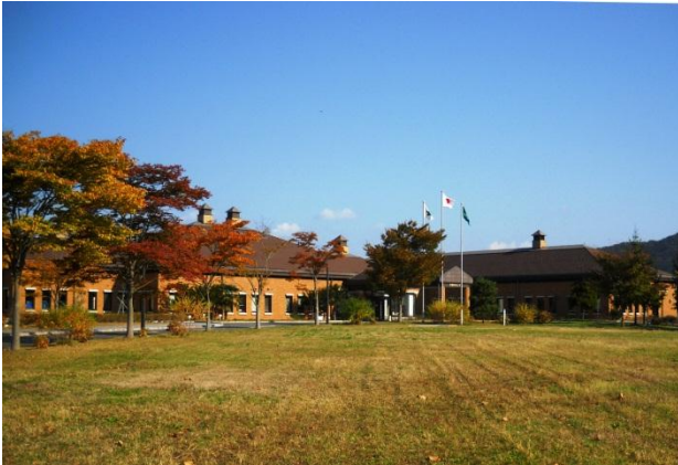
石巻浄化センター
