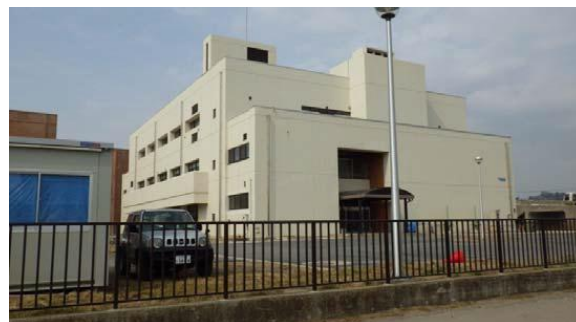
石巻東部浄化センター
