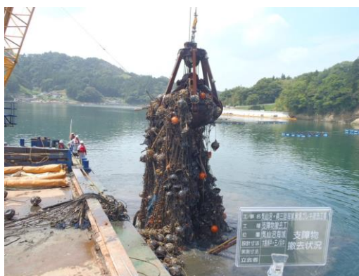
【専門業者による沿岸のガレキ撤去】
