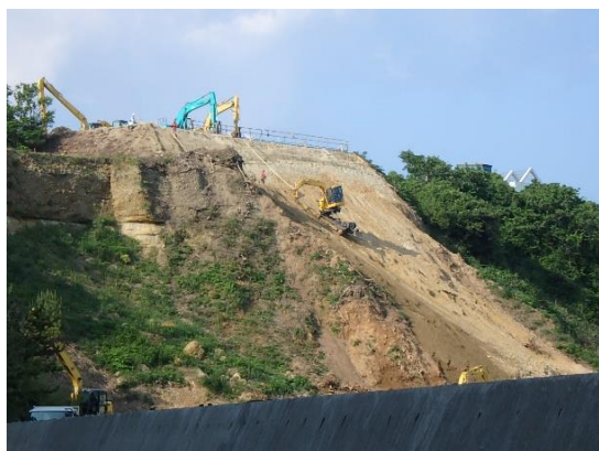
登米沢地区（高所法面掘削機による切土施工）
