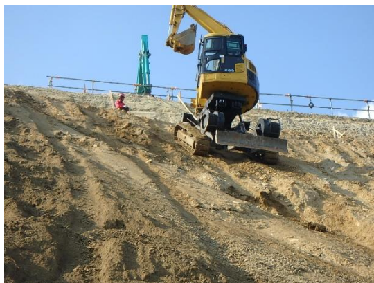
登米沢地区（高所法面掘削機による切土施工）
