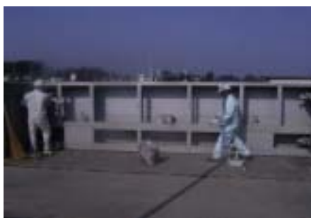
(陸閘点検の様子)
