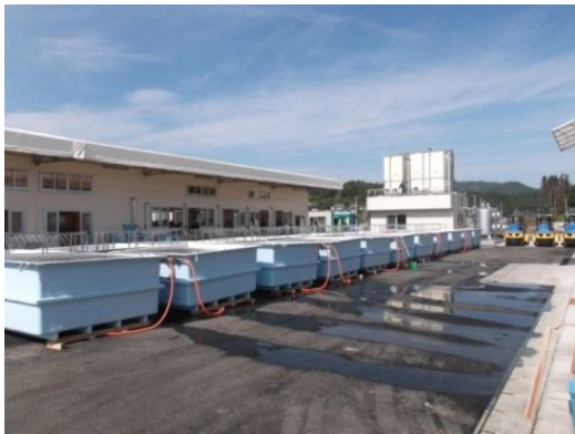
(完成した志津川カキ共同処理場)
