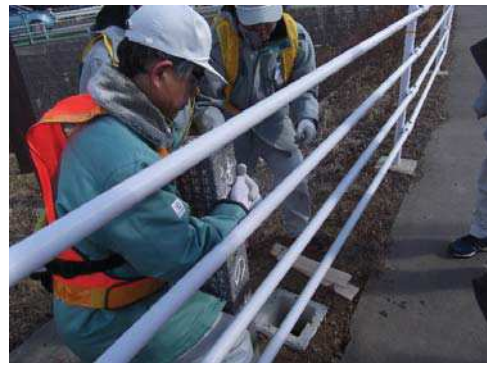
気仙沼唐桑線での作業状況
