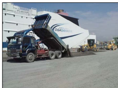
日和6号埠頭の応急復旧工事の様子
