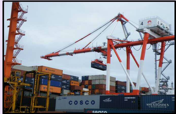
平成24年1月22日 ガントリークレーン4号機
