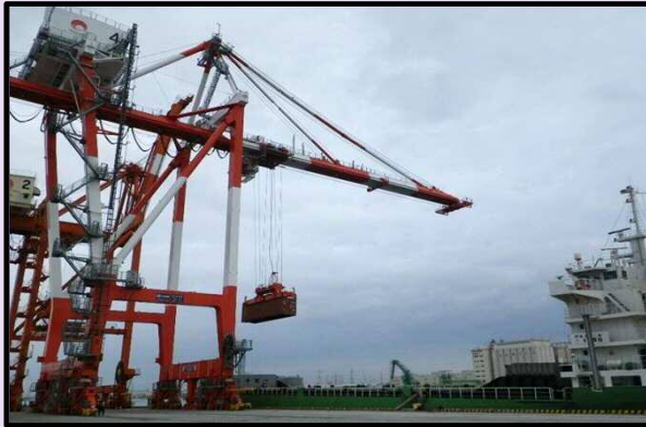
平成24年1月20日 ガントリークレーン4号機
