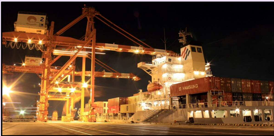
平成23年12月26日 1号機、2号機2基同時荷役
