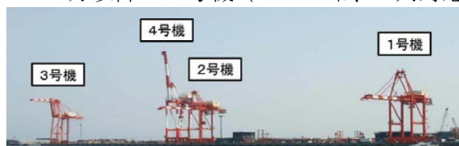
●海側から見たガントリークレーンの配置
