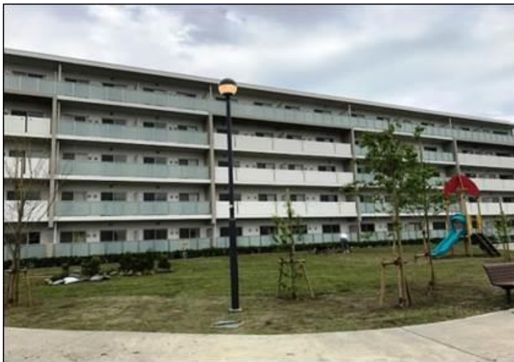
災害公営住宅(名取市閑上)
